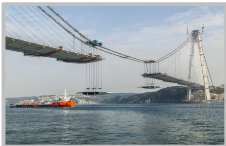
현수교 케이블 가설장비 국산화 (보스포러스 제 3교)
