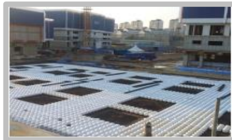
이방향 중공슬래브 공법(오금동 보금자리주택)
