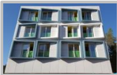
조립식 공동주택 실증 (가양동)
