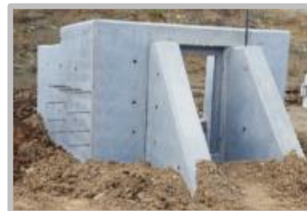
방호·방폭용 고성능 섬유보강시멘트 (영천 공병훈련장)
