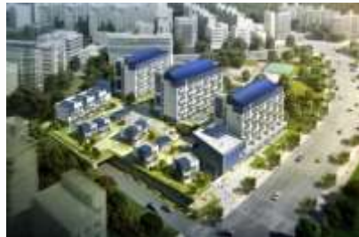
제로에너지 공동주택 실증 착수
